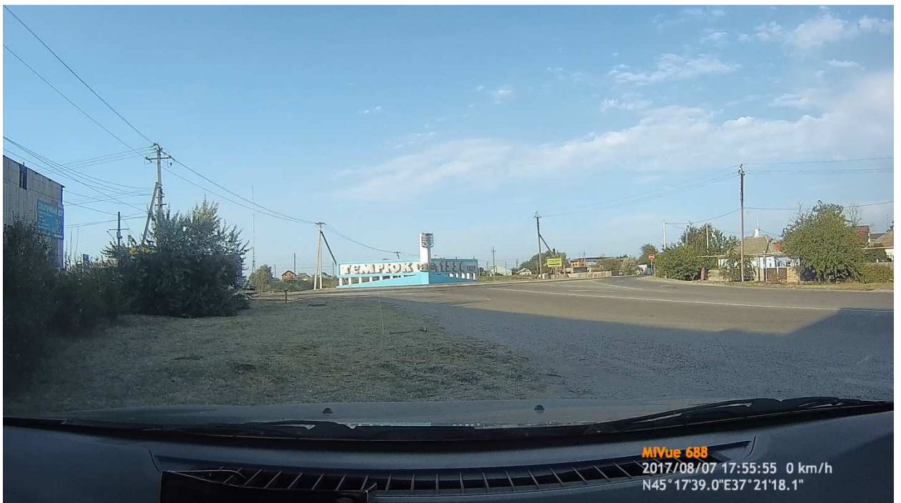
Фото места проведения обследования.
