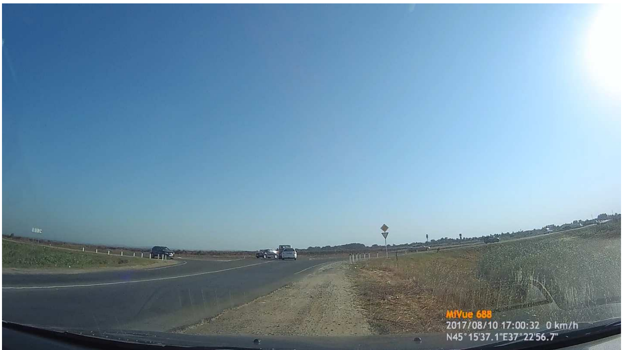
Фото места проведения обследования.
